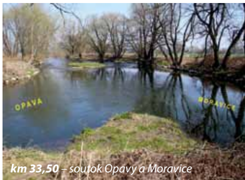
stupeň u Pilszczkého potoka
